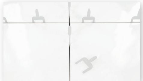
Sobald das Kleberbett ausgehärtet ist, entfernen Sie die Keile (mehrmals verwendbar), und die Gewindelassen (Abtreten oder Abschlagen) in Fugenrichtung.
