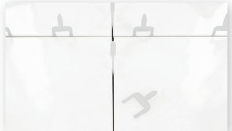
Die Gewindelassen in Fugenrichtung entfernen. (Abtreten oder Abschlagen)
