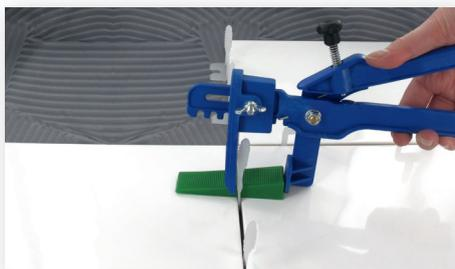
Und drücken Sie diesen mit der Verlegezange fest in die Gewindelasse hinein. Somit werden die beiden Fliesen auf die selbe Höhe ausgerichtet.
